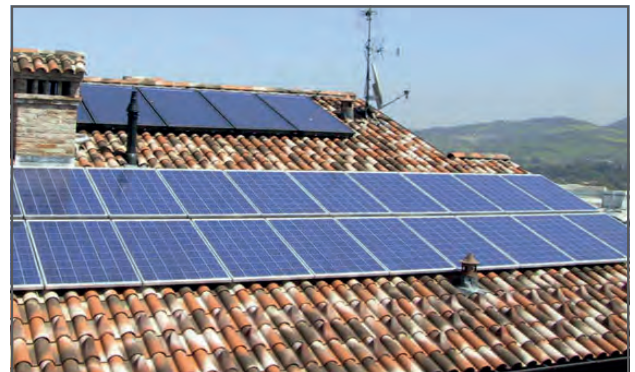
Es. Copertura tetto con pannelli e antenne
